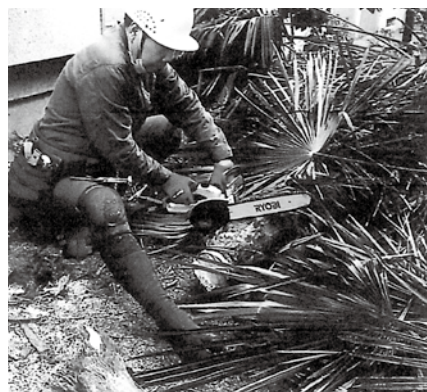
棕櫚の伐採後の処理作業、幹は廃棄しやすく約25cmでカットイン、事前に葉鞘除去してあるので巻き込みがなく安全に比較的早く作業が進行する。
