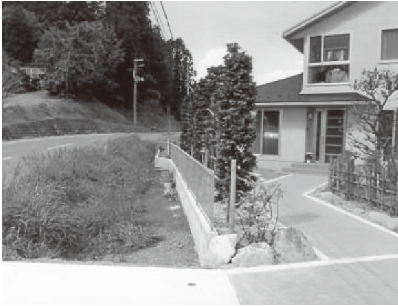
施工したS邸の庭
